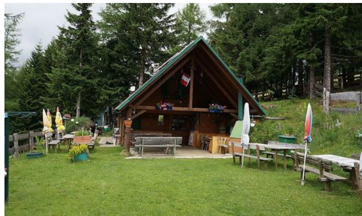
Die Liedlhütte liegt auf 1501 Metern in Bad St. Leonhard © Hollauf
